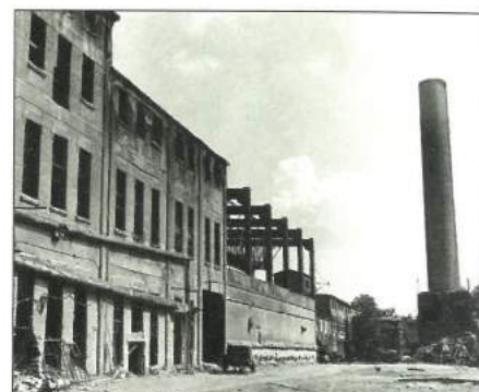
Poslední fotografie staré cementárny před demolicí v roce 1975.
