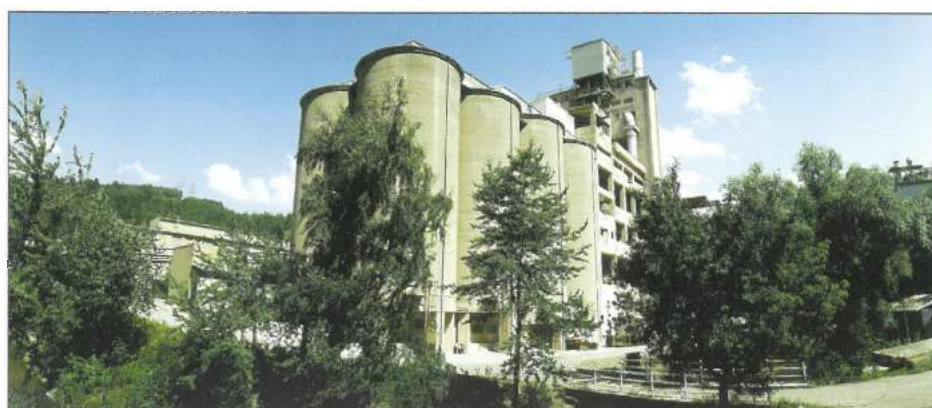
■ Pohled na výrobní část závodu Radotín dnes. Radotínská cementárna se díky rekonstrukci po roce 1989 stává závodem evropské úrovně.
