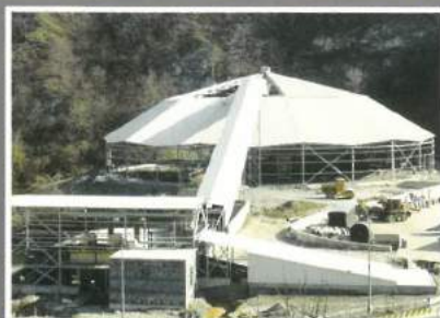
Záběr z výstavby skládky, jaro 1997.
