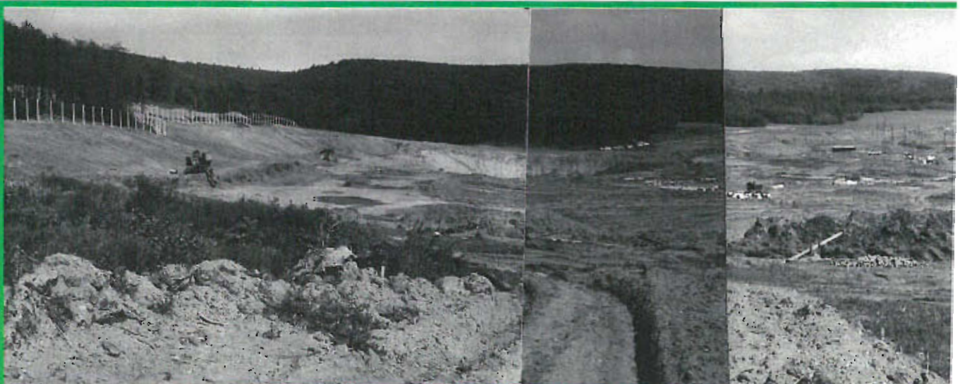
Panoramatický pohled na staveniště 4.6. 1962
