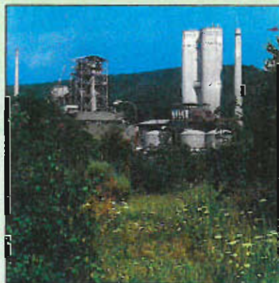
Celkové pohledy na cementárnu a vápenku v 90. letech
